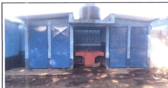
Foto 5: Reparación y cambio de puertas y pilas.
