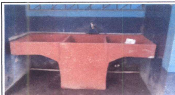
Foto 3: Instalaciones de pilas nuevas
