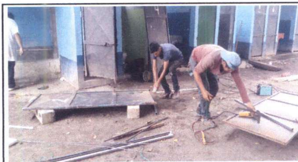
Foto 5: Reparación y cambio de puertas.
