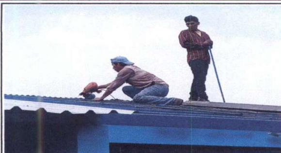
Foto 1: Mantenimiento y cambio de láminas módulo 3
