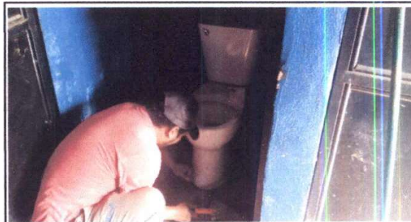
Foto 4: Reparación cambio y mantenimiento de sanitarios
