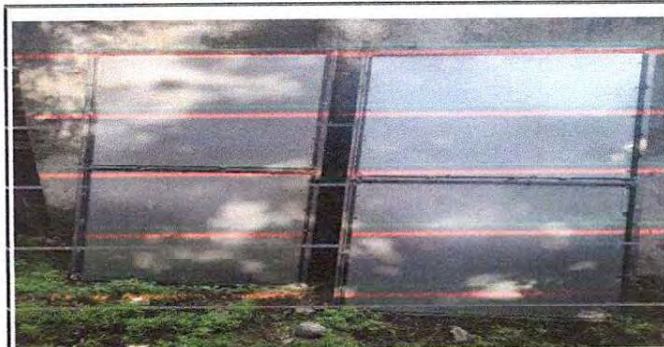
Foto 4: Sustitución de puerta de aulas
