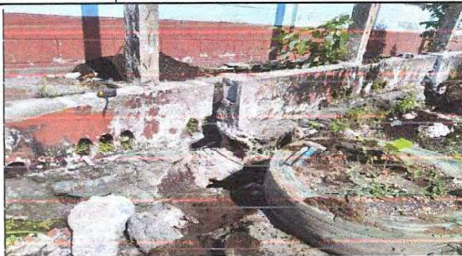
Foto 2: Reparación de Muro perimetral de Block
