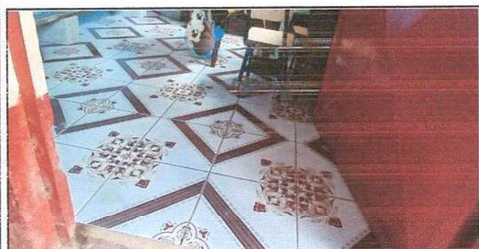
Foto 5: sustitucion de tora de cemento por piso ceramico en direccion
