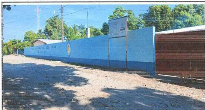
Foto 1: Pintura en muro perimetral
