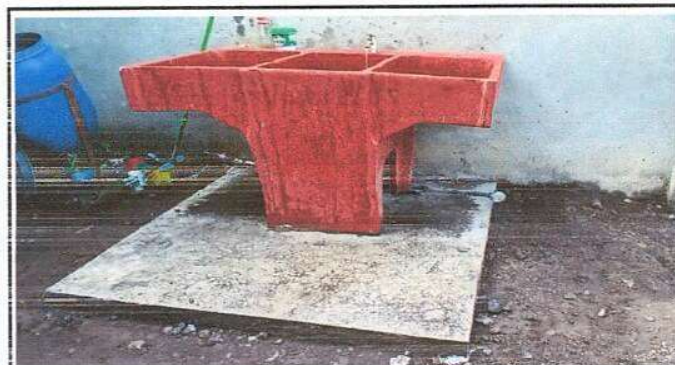
Foto 4: sustitución de pila de concreto
