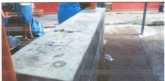
Foto 3: elaboración de mesa de concreto
