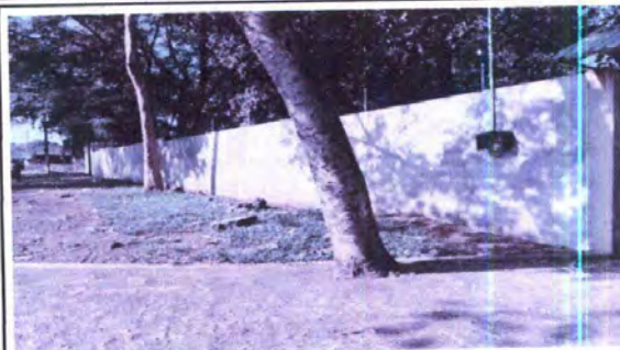
Foto 2: REPARACION DE REPELLO Y CERNIDO EN PARED DE MURO PERIMETRAL MODULO 1
