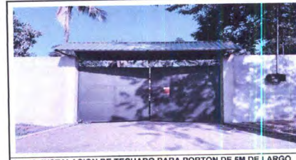
Foto 6: INSTALACION DE TECHADO PARA PORTON DE 5M DE LARGO POR 2.40M DE ANCHO, CON TUBO CUADRADO GALVANIZADO.
