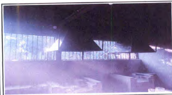
Foto 5: INSTALACION DE DOS CHIMENEAS DE ESTUFAS RURALES.
