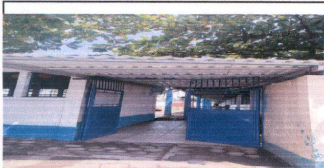
Foto 7: mantenimiento y reparacion de porton entrada principal.
