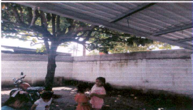
10.levantamiento altura de block , en pared perimetral
