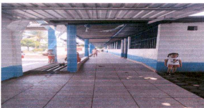
Foto 5: sustitucion de piso de concreto en mal estado, piso de concreto nuevo y ceramico en pasillo.
