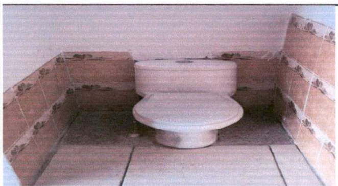
Foto 9: sustitucion de inodoros
