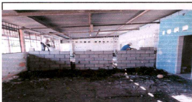
Foto 6: sustitucion de pared de madera por pared de block(levantado, cernido y repello)
