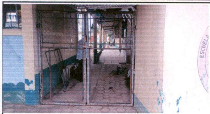
Foto7: mantenimiento y reparacion de porton entrada principal.
