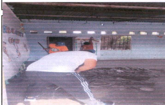
Foto 4: sustitucion de piso de concreto en mal estado por piso de concreto nuevo en aulas.
