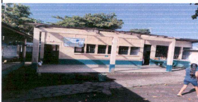
Foto1:sustitucion de lamina de zinc acanalada
