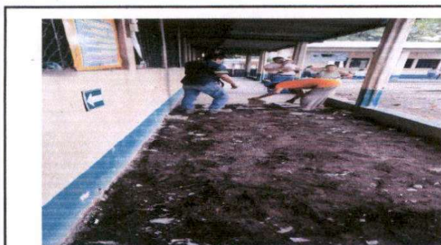
Foto 5: sustitucion de piso de concreto en mal estado, piso de concreto nuevo y ceramico en pasillo.
