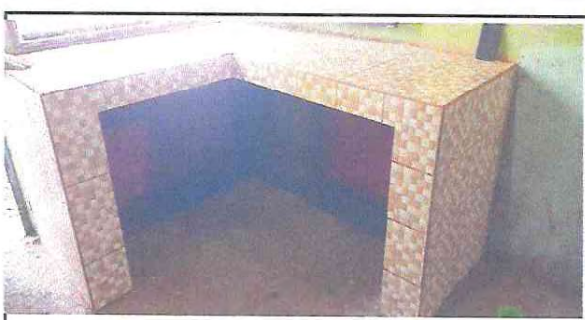
Foto 6: Instalación de azulejo en plancha de cemento
