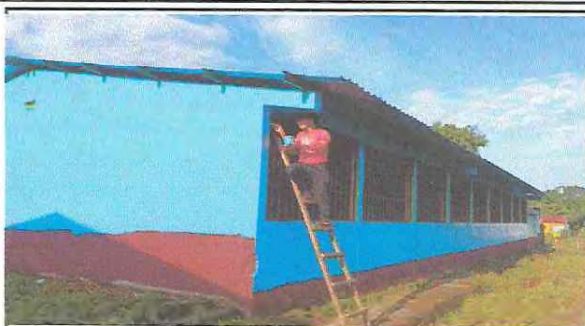
Foto 2: Sustitución de estructura de metal parte trasera del primer modulo 3 aulas y mantenimiento de estructura de soporte de metal
