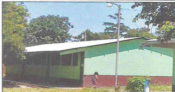
Foto1: Sustitución de cubierta de lámina troquelada calibre 26, sustitución de 3 puertas de metal con chapa
