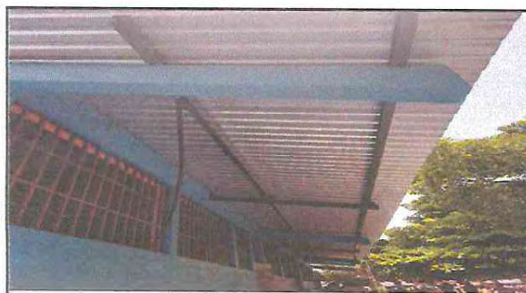
Foto 3: Sustitución de estructura de metal corredor principal
