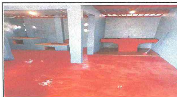
Foto 10: Sustitución de piso de torta a piso de cemento liquido en la cocina.
