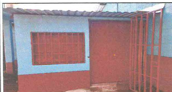
Foto 9: Fabricación e instalación de ventana, balcon de metal,fabricación e instalación de puerta de metal ,reparación e instalación de puerta de reja.
