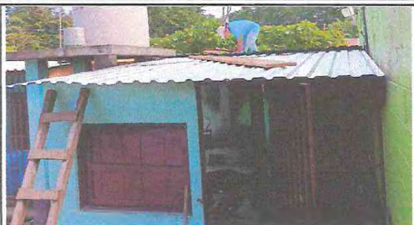
Foto1: Sustrucción de cubierta de lámina de cocina
