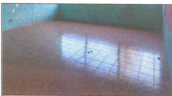
Foto 4: Sustitución de piso de cemento liso a piso ceramico de 3 aulas
