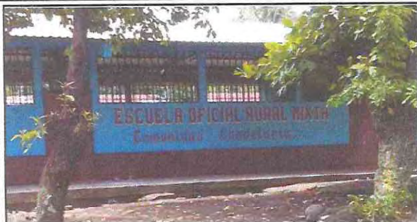
Foto7: Pintura de exterior e interior del primer modulo de 3 aulas
