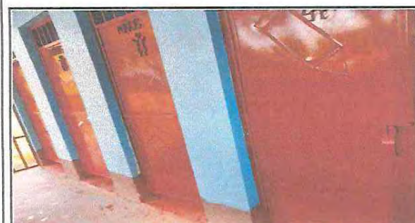
Foto 11: Reparación e instalación de 7 en los servicios sanitarios.
