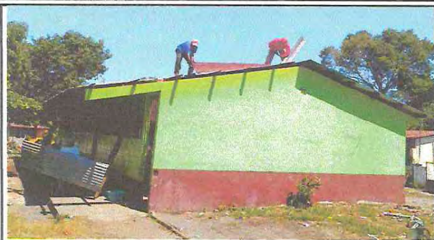
Foto1: Sustitucion de cubierta de lamina troquelada
