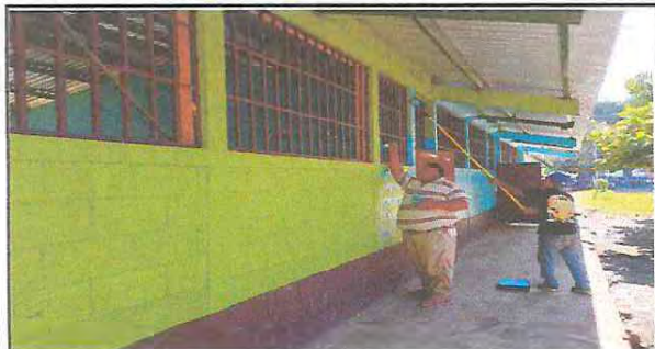
Foto 7: Pintura exterior e interior del primer modulo 3 aulas
