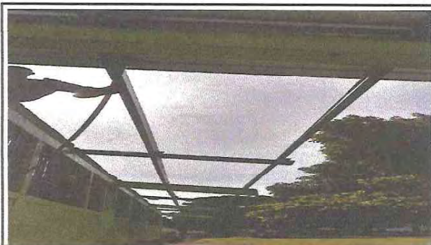
Foto 3: Sustitucion de estructura de metal corredor principal
