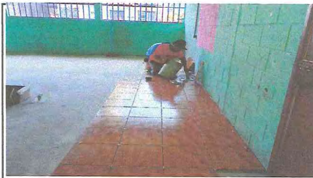
Foto 4:Sustitución de piso de cemento liso a piso de ceramico para interior de 3 aulas
