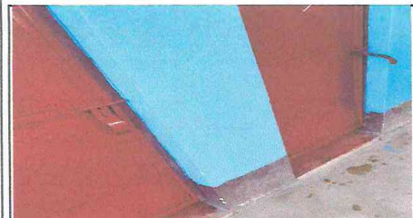
Foto 11: Reparación e instalación de 7 puertas de metal en los servicios sanitarios.
