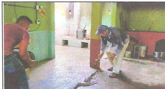
Foto 10: Sustitución de piso de torta a piso de cemento liso.
