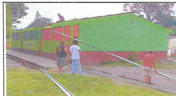
Foto 12: Sustitución de estructura de metal en parte trasera del modulo 1
