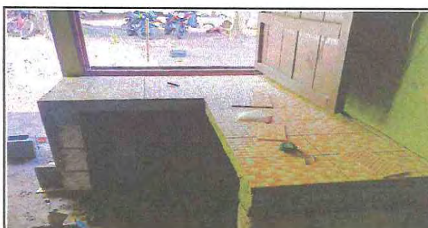
Foto 6: instalación de azulejo en plancha de cemento
