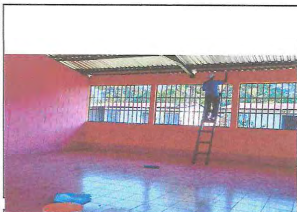
Foto1: Sustitución de cubierta de lámina de cocina
