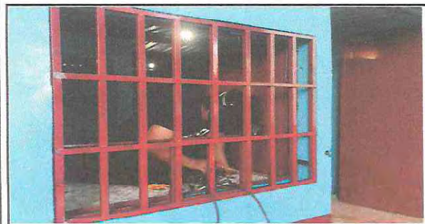
Foto 9: Fabricación e instalación de ventana, balcon de metal fabricación e instalación de puerta de metal, reparación e instalación de puerta de reja.
