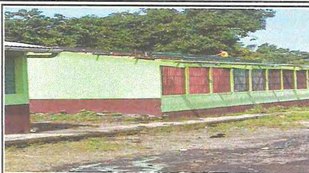
Foto 2: Mantenimiento de estructura de metal
