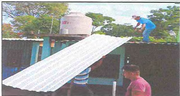
Foto1: Sustitución de cubierta de lámina de cocina
