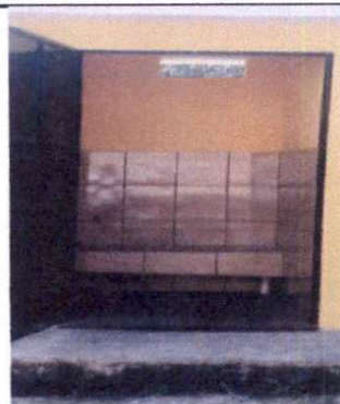
Foto 4: instalación de azule en baños
