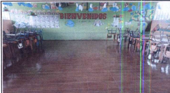
Foto 2: sustitución de torta de cemento por piso cerami en aula
