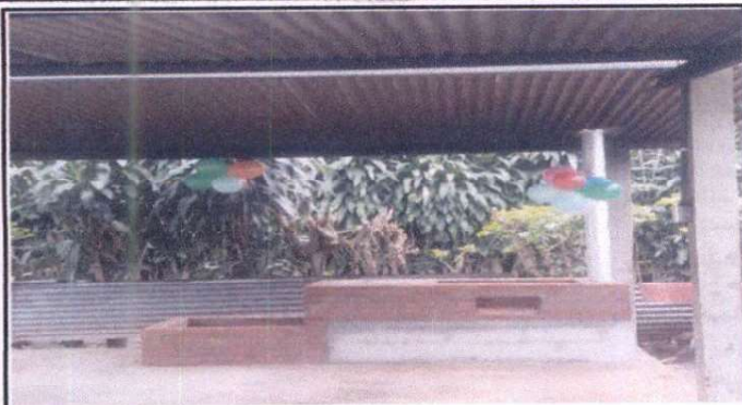
Foto1: Sustitución de piso cerámico
