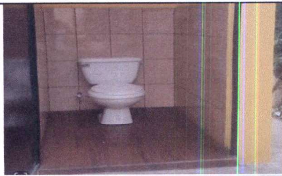
Foto 6: sustitución de tazas de sanitario, sustitución de torta de cemento por piso ceramico
