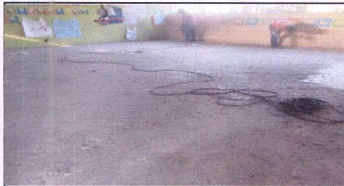
Foto1: Sustrución de tora de semento por piso ceramico
