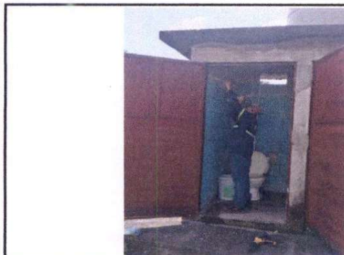
Foto 3: mantenimiento de puertas de baños
