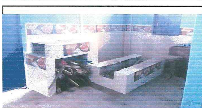
Foto 4: sustitucion de piso de concreto por ceramico, Instalacion de estufa rural. e instalacion de azulejo en estufa rural, parte superior.
