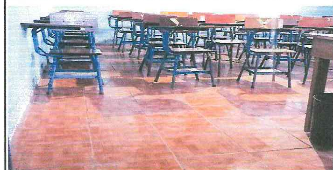
Foto 6: sustitucion de piso de concreto por piso ceramico por encontrarse en mal estado en aulas
