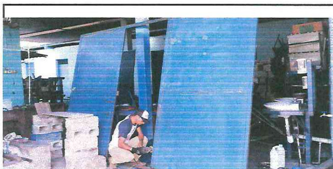
Foto 5: mantenimiento en estructura de metal , portones
