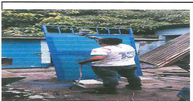
Foto 3: mantenimiento a estructura de metal puerta.
