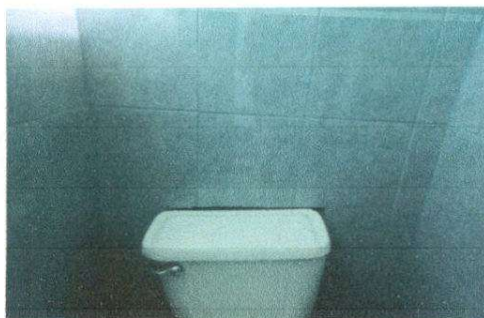
Cambio de tapadera dañada.
