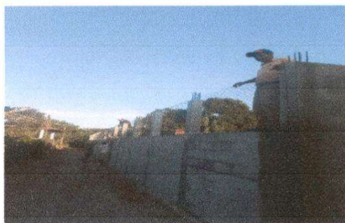
Muro terminado y colocación de malla.
