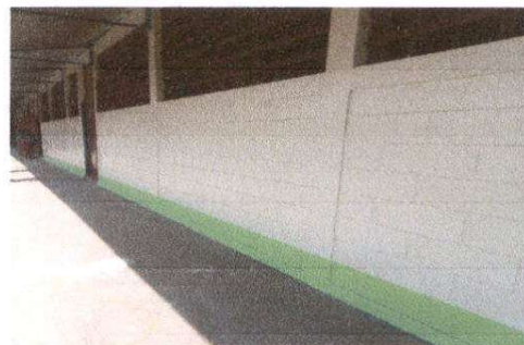
Pintura completa en muros de interiores y exteriores.
