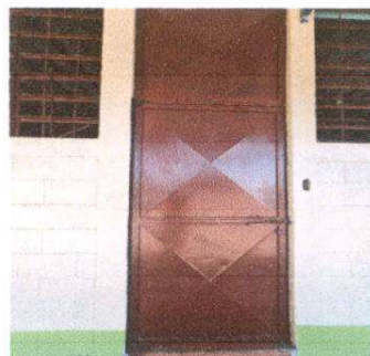
Pintura de puertas completa.
