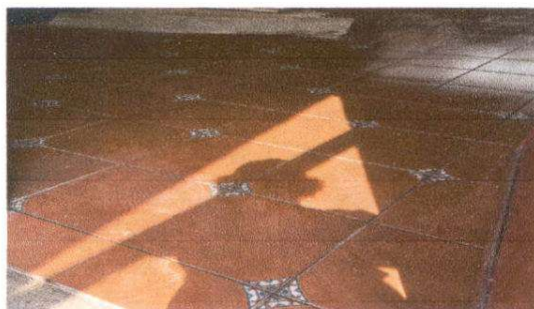
Piso ceramico colocado.
