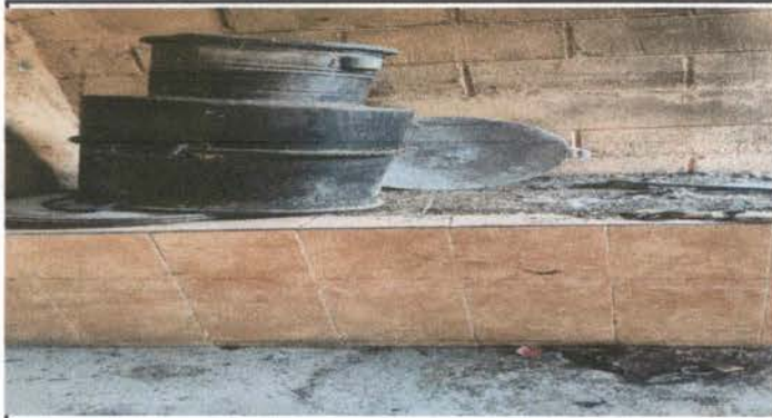
Foto1: Remodelación de Poyetòn con chimenea
