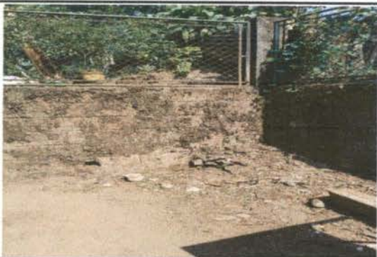
Foto 5: Levando de muro perimetral de 3 hiladas de Block
