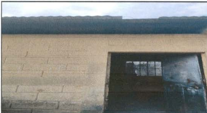
Foto 3: Cambio de Puera Cocina
