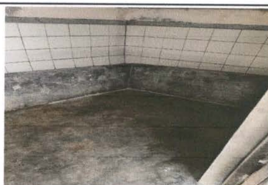
Foto 4: Remodelación de Migitorio
