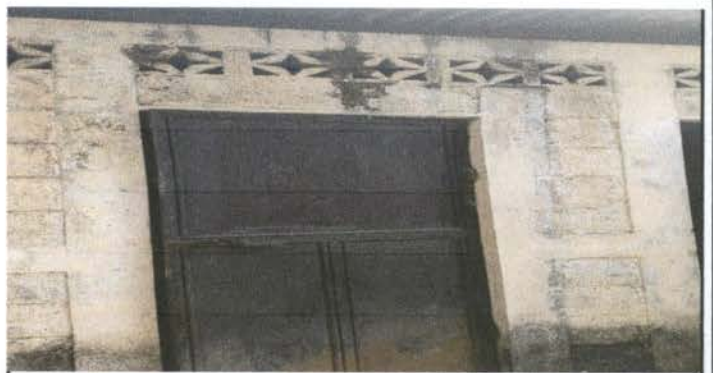
Foto 6: Repello y cambio de lámina sanitarios
