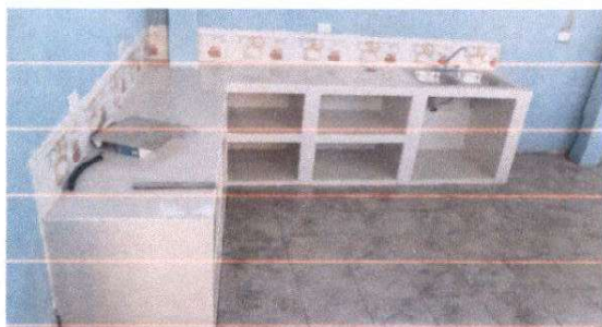
Foto 5: CONSTRUCCIÓN DE GABINETE, REVESTIMIENTO DE AZULEJO E INSTALACIÓN DE TOMACORRIENTES
