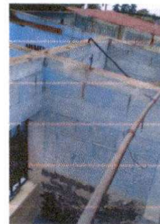
Foto 4: CAMBIO DE COSTANERAS Y TECHO DEL BAÑO
