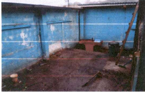
Foto 1: NIVELACIÓN DE PISO DE LA COCINA
