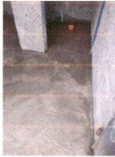
Foto 1: LEVANTADO DE PISO PARA NIVELACIÓN DE LOS BAÑOS
