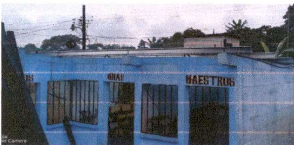
Foto 5: CAMBIO DE COSTANERAS
