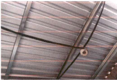
Foto 3: CAMBIO DEL CABLEADO ELECTRICO
