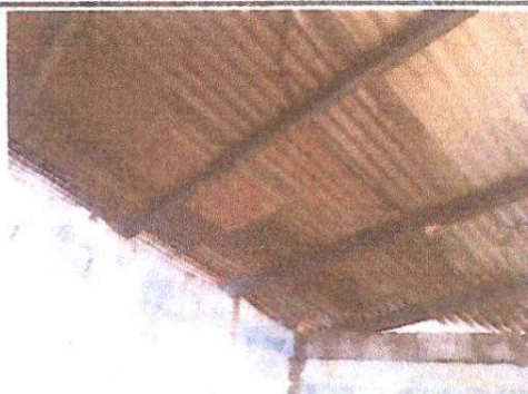
Foto 5: SUSTITUCIÓN DE LAMINAS Y COSTANERAS QUE ESTAN EN MAL ESTADO
