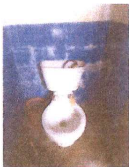
Foto1: CAMBIO DE SANITARIOS
