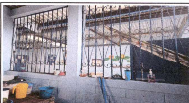
Foto 4: Sustitución de balcones de metal
