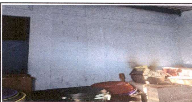
Foto 6: Repello en muro
