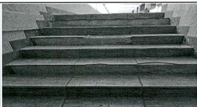
Sustitución de piso en gradas
