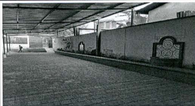
Aplicación de pintura en piso de patio
