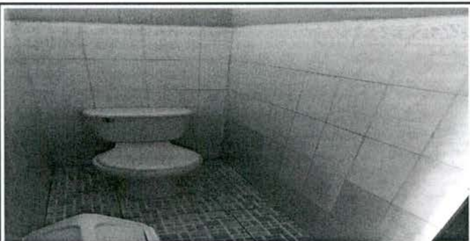
Sustitución de inodoros
