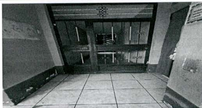
Sustitución de puertas de rejas
