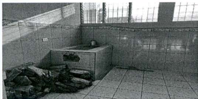
Sustitución de polletón
