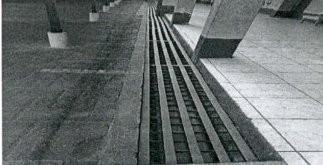
Mantenimiento de rejillas de metal
