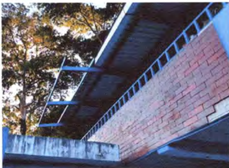
Ampliación de techo sobre sanitarios, Módulo Norte
