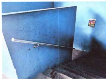
Pasamanos en graderío, Módulo sur
