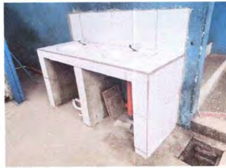
Construcción de 2 lavamanos, Módulo Sur
