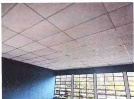
Cielo falso de aulas, módulo sur
