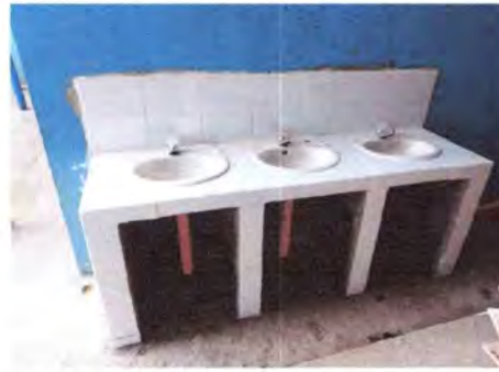
Construcción de 3 lavamanos, módulo Norte
