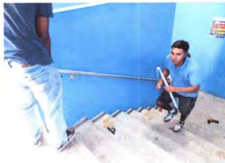
Pasamanos en graderío, Módulo sur
