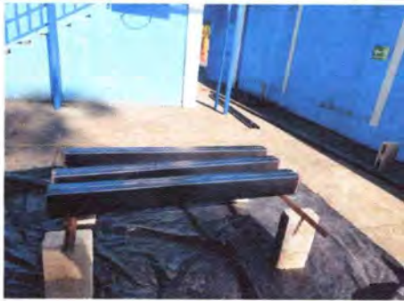
Ampliación de techo sobre sanitarios, Módulo Norte
