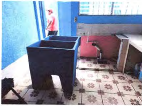
Cambio de lavatrastos por pila de 1 lavadero en cocina escolar, módulo Norte
