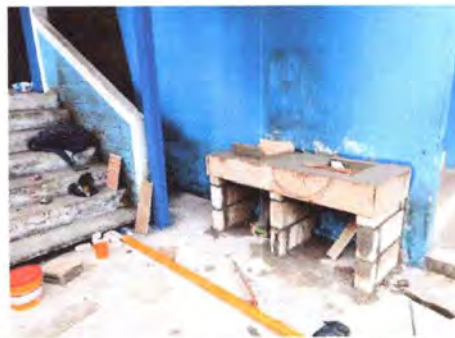
Construcción de 2 lavamanos, Módulo Sur
