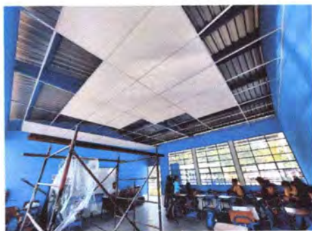
Cielo falso de aulas, módulo sur
