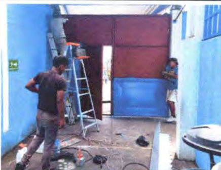
Mantenimiento de porton de ingreso, lijado y pintura, módulo Norte
