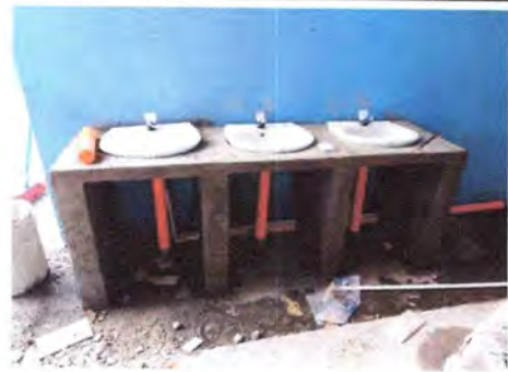
Construcción de 3 lavamanos, módulo Norte
