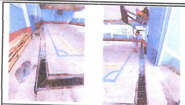
TRABAJOS EN AREA DE CANCHA POLIDEPORTIVA, PATIO Y MODULO DE GRADAS
