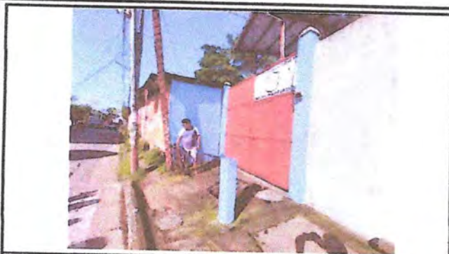
Mejoramiento de Ingreso a Escuela
