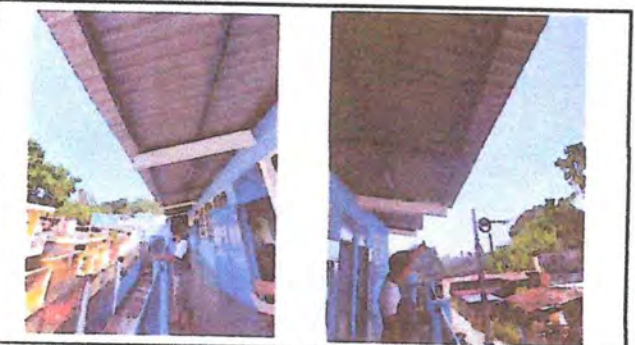
CANALES Y BAJADAS DE AGUA PLUVIAL
