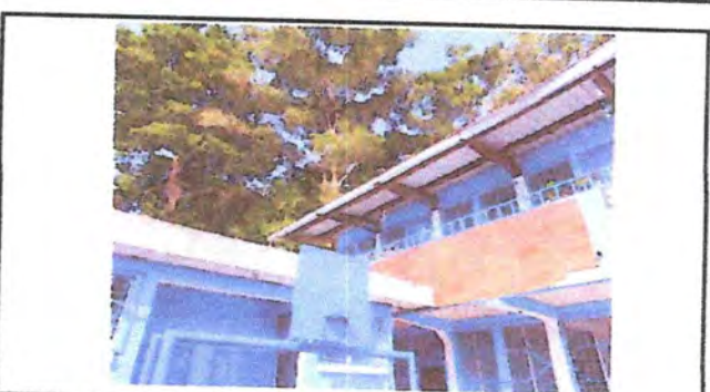
CANALES PLUVIALES CAMBIO DE CAIDA
