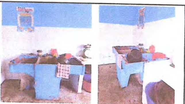
CONSTRUCCION DE POYETON AJUSTADO PARA ESCUELA Y CAMBIO DE PILA
