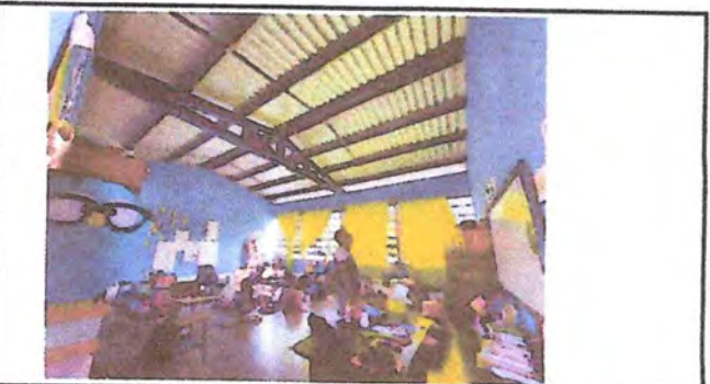
Cielo Falso Aulas
