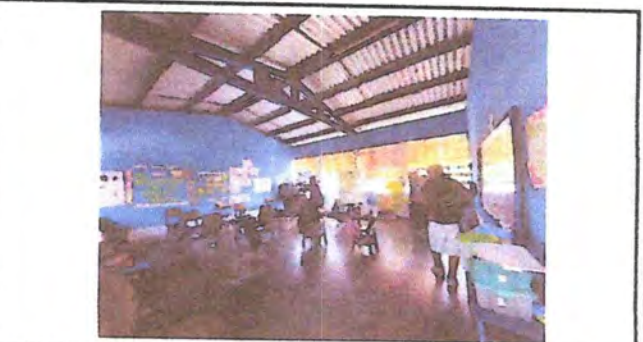
Cielo Falso Aulas
