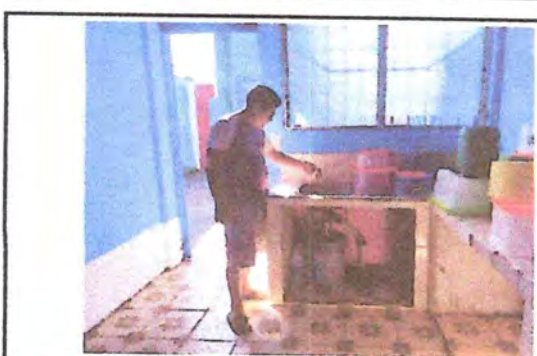
Cambio de Pila de cemento en cocina estandar de un lavadero
