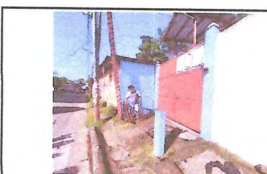
Mejoramiento de Ingreso a Escuela
