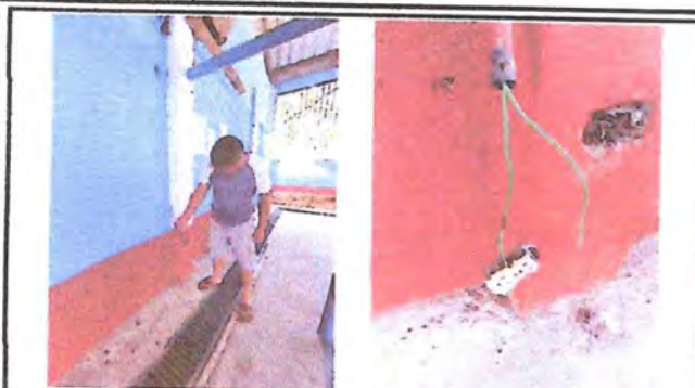
TRABAJOS EN AREA DE CANCHA POLIDEPORTIVA, PATIO Y MODULO DE GRADAS
