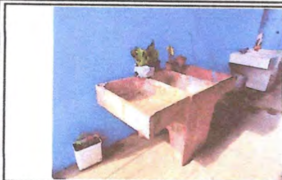
Construcción de lavamanos de concreto con 3 grifos.
