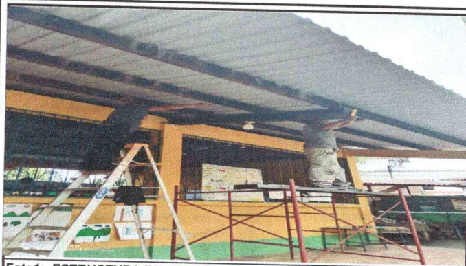
Foto1: ESTRUCTURA DE TECHO
