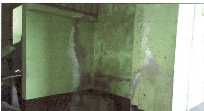
Foto 11: Debido al estado de deterioro de la losa del techo, las instalaciones del establecimiento se han visto afectadas, solicitan el remozamiento de dicha losa.
