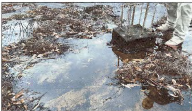
Foto 9: Debido al estado tan grave de deterioro en el que se encuentra la losa del techo, solicitan trabajos de remozamiento en esta área.
