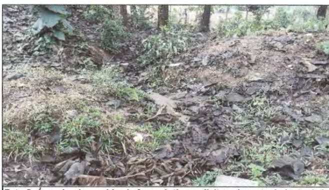
Foto 5: Área donde se ubica la fosa séptica, solicitan el mantenimiento de la fosa debido a que ha pasado tiempo desde que esta se realizó.
