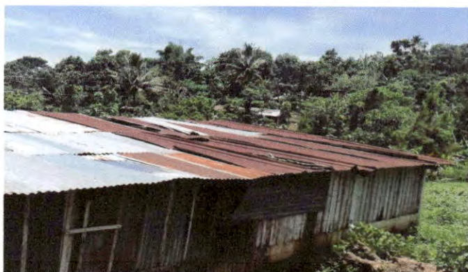
Foto 4: Solicitan trabajos de remozamiento en módulo de aulas. Entre los trabajos solicitados está el cambio y reparación de la cubierta de lámina.
