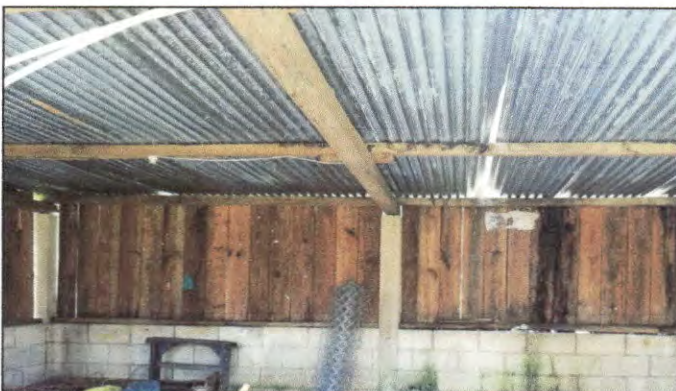
Foto 3: Solicitan trabajos de remozamiento en módulo de aulas. Entre los trabajos solicitados está el cambio y reparación de la cubierta de lámina.
