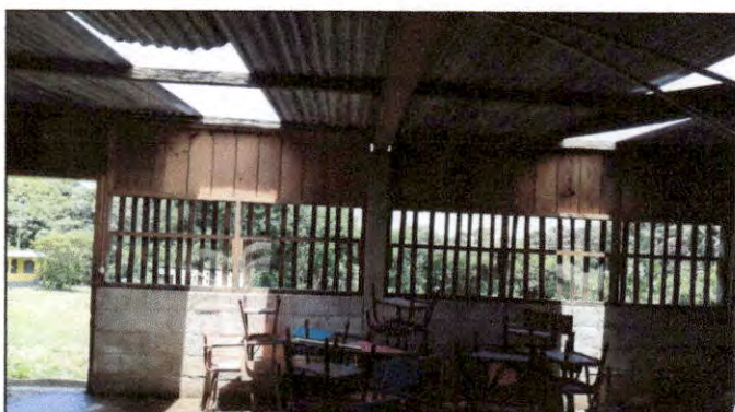
Foto 6: Debido al mal estado en el que se encuentra, se solicita la reparación urgente de la cubierta de lámina en módulo de aulas.
