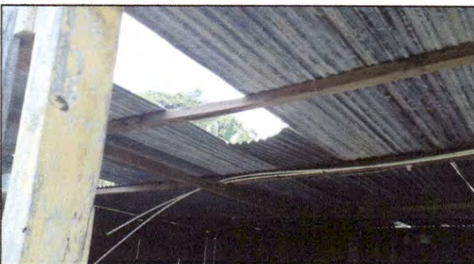
Foto 5: Debido al mal estado en el que se encuentra, se solicita la reparación urgente de la cubierta de lámina en módulo de aulas.
