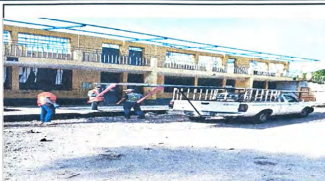
FOTO 2: CAMBIO DE LAMINA
