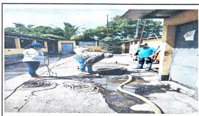
FOTO 4: LIMPIEZA DE FOSAS SEPTICAS
