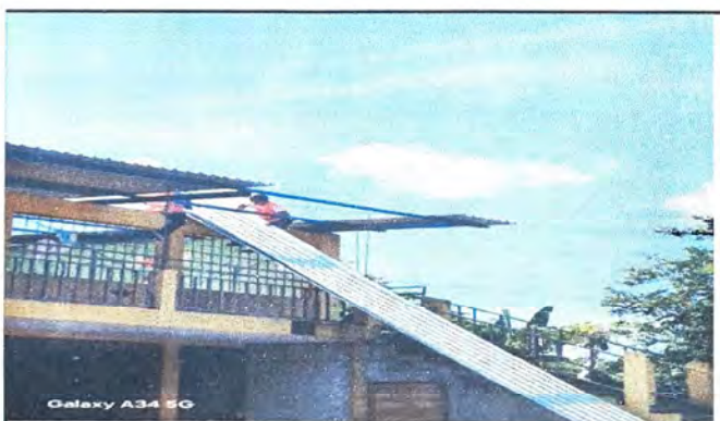
FOTO 3: CAMBIO DE LAMINA
