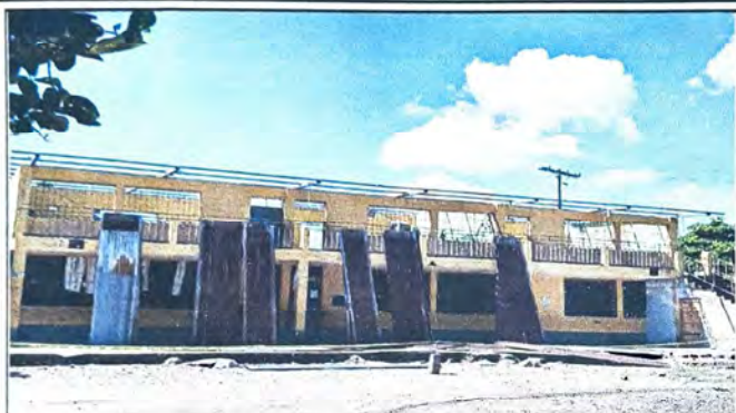
FOTO 1: CAMBIO DE LAMINA
