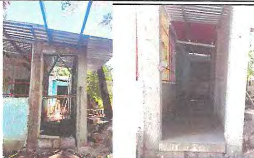
Foto 2: cambio de alambre de pua por muro de concreto y su torta de cemento
