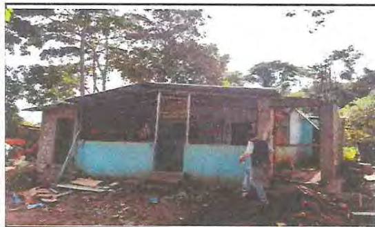
Fabricación de grada de cocina
