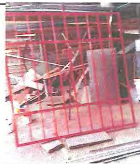
Fabricación de balcon de cocina
