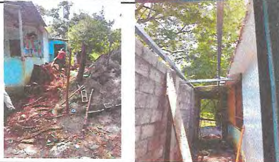
Foto 1: cambio de alambre de pua por muro de concreto y su torta de cemento
