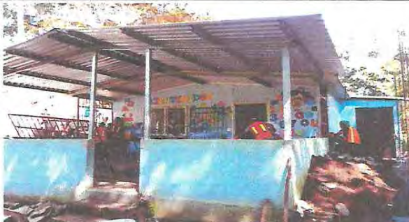
Foto 8: Sustitución de lámina, por lámina troquelada aluzinc 26
