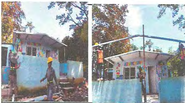
Foto 5: Estructura de techo. Se cambia la estructura de bambú por estructura metálica, con la creación de balcones de metal.
