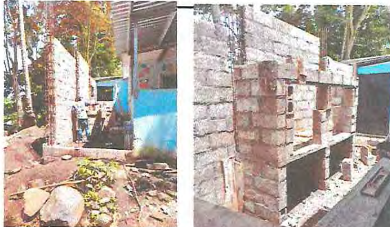
Foto 4: Ampliación de Cocina
