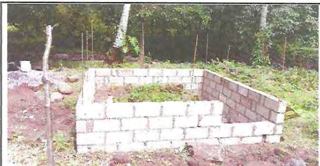
Foto 6: levantado de Block para el poso. Trabajado con material del proyecto pero mano de obra municipal
