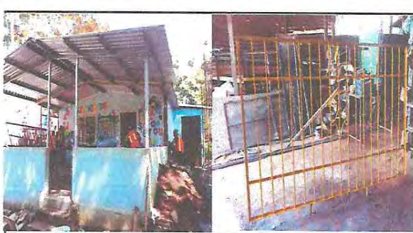
Foto 6: Estructura de techo. Se cambia la estructura de bambú por estructura metálica, con la creación de balcones de metal.
