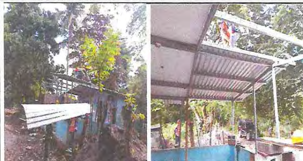
Foto 7: Sustitución de lámina, por lámina troquelada aluzinc 26
