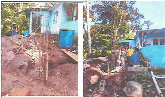
Foto 3: Ampliación de Cocina
