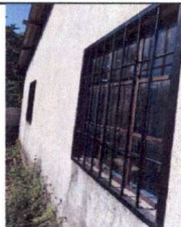
Foto 6: Sustitución de ventana de vidrio por balcon de metal.
