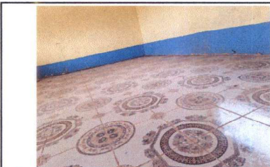
Foto 3: Sustitución de piso de concreto por piso cerámico.
