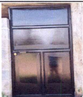
Foto 5: Sustitución de puerta de metal.
