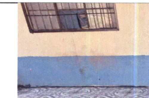
Foto 6: Sustitución de ventana de vidrio por balcon de metal.
