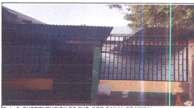
Foto 6: SUSTITUTUCION DE PVC POR CANAL DE METAL
