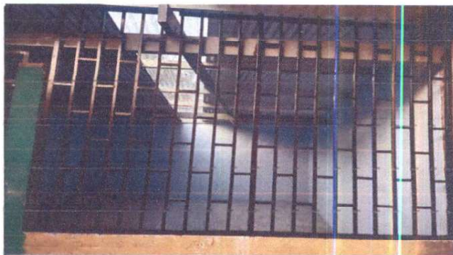
Foto 4: SUSTITUCIÓN DE VENTANAS DE MADERA POR METAL
