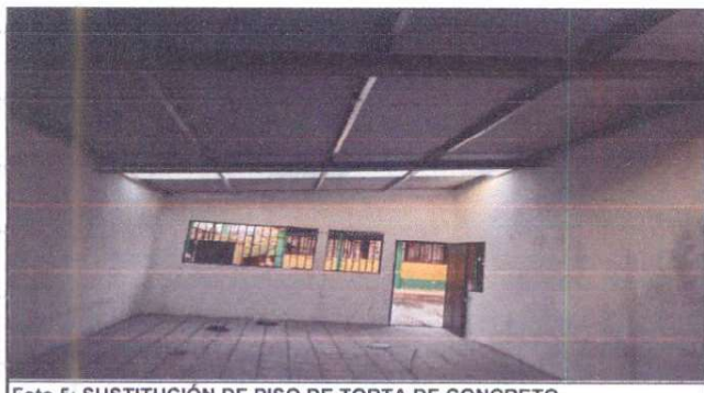
Foto 5: SUSTITUCIÓN DE PISO DE TORTA DE CONCRETO
