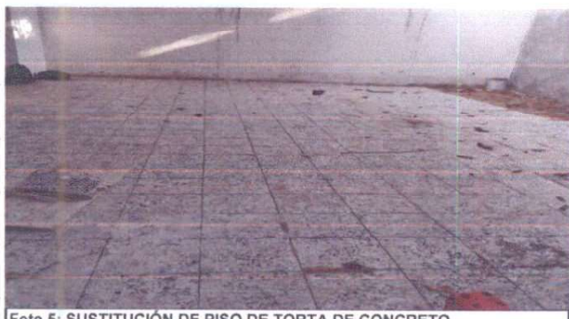
Foto 5: SUSTITUCIÓN DE PISO DE TORTA DE CONCRETO
