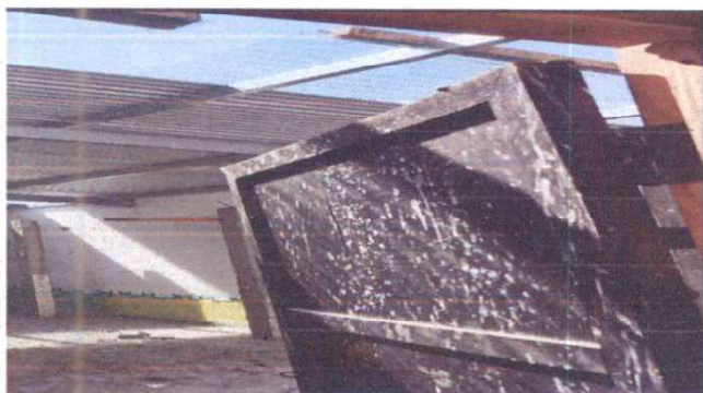
Foto 3: SUSTITUCIÓN DE PUERTA
