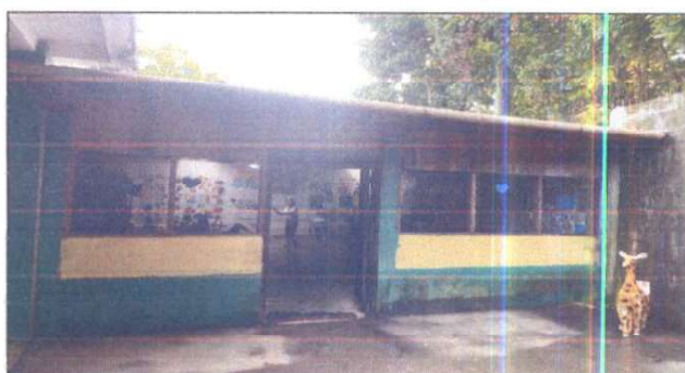
Foto 6: SUSTITUTUCION DE PVC POR CANAL DE METAL
