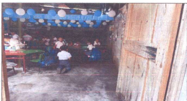
Foto 5: SUSTITUCIÓN DE PISO DE TORTA DE CONCRETO
