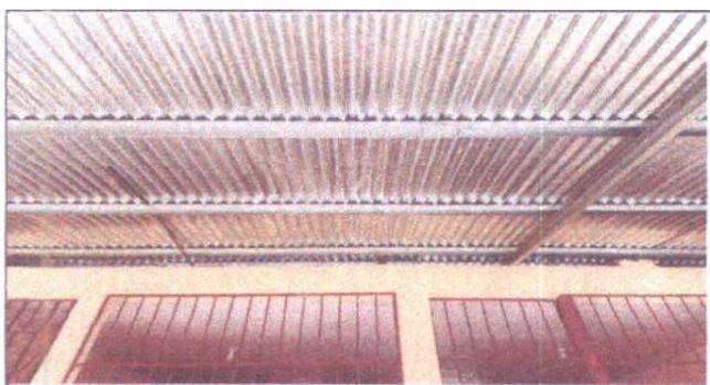
Foto 5: Se instalo lamina galvanizada
