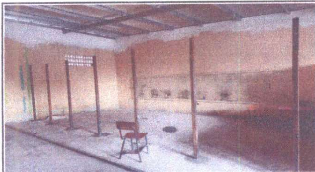
Foto 3: Se insertaron tubos de metal para la separacion
