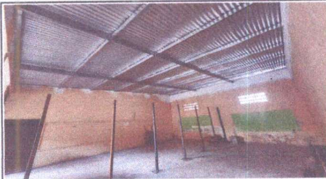
Foto1: Se esta modificando los espacios
