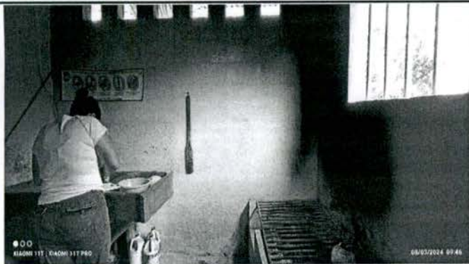
Instalación de balcón en ventana
