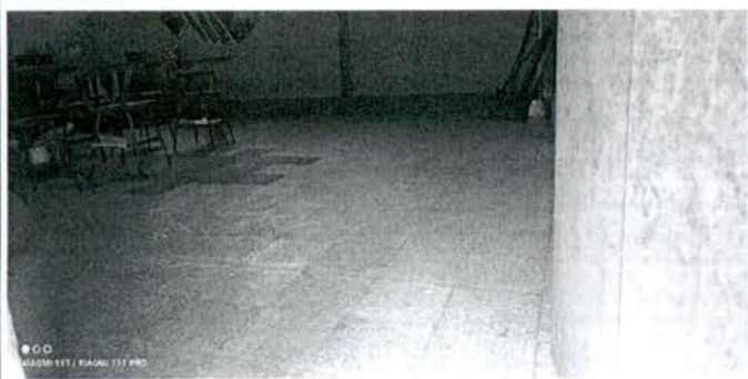
Pulido de piso de granito
