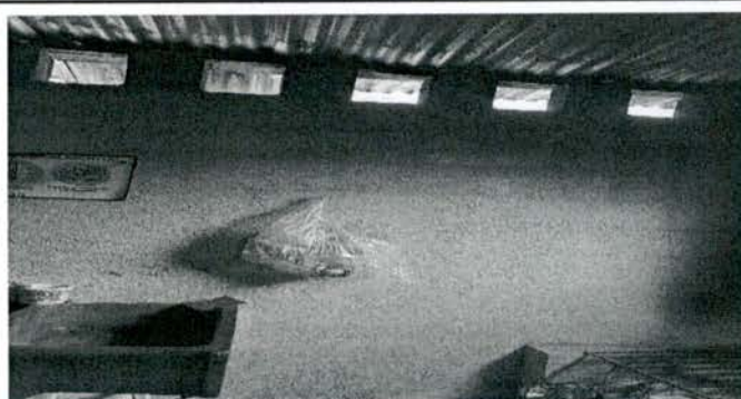
Sustitución de lámina por lámina troquelada calibre 26
