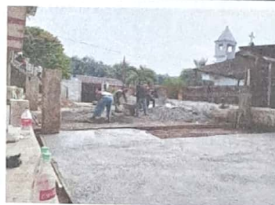
Foto 6: FOTOGRAFIA REPARACION DE PLANCHAS DE CONCRETO DE PATIO (0.10M) DE ESPESOR
