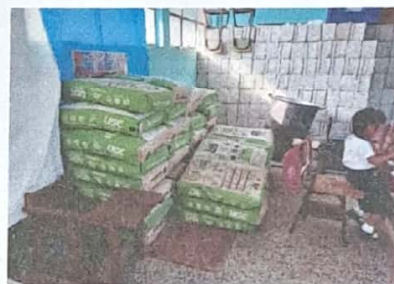
Foto 4: FOTOGRAFIA SUMINISTRO DE MATERIAL
