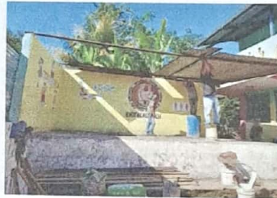
Foto 10: FOTOGRAFIA RETIRO DE LAMINA EN ESCENARIO
