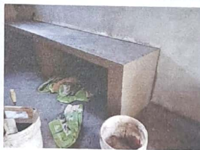
Foto 12: FOTOGRAFIA MEJORAMIENTO BANCA DE CEMENTO EN COSINA
