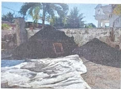
Foto 3: FOTOGRAFIA SUMINISTRO DE MATERIAL
