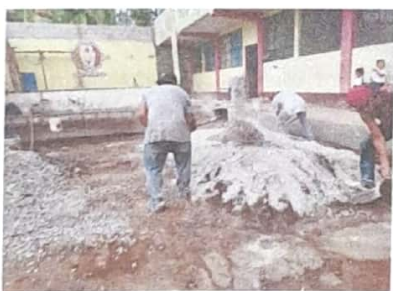
Foto 5: FOTOGRAFIA REPARACION DE PLANCHAS DE CONCRETO DE PATIO (0.10M) DE ESPESOR
