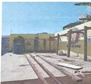
Foto 11: FOTOGRAFIA RETIRO DE ESTRUCTURA DE MADERA EN ESCENARIO
