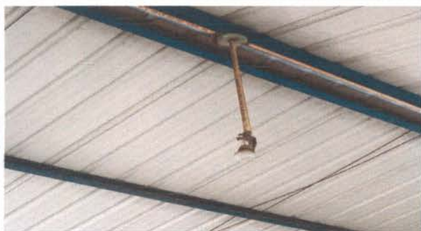
Sustitución de cableado eléctrico, cajas octogonales, plafoneras y focos en módulo de aulas
