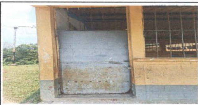
Mantenimiento de puertas de metal en módulo de aulas
