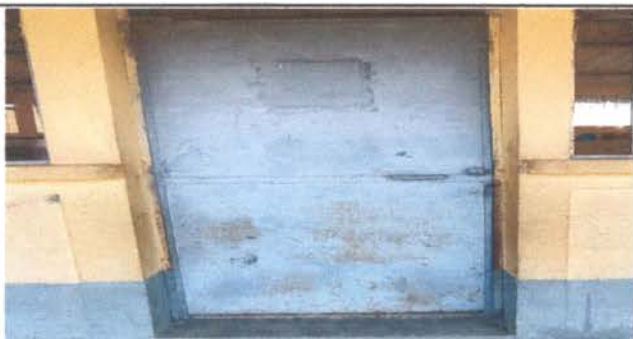
Mantenimiento de puertas de metal en módulo de aulas
