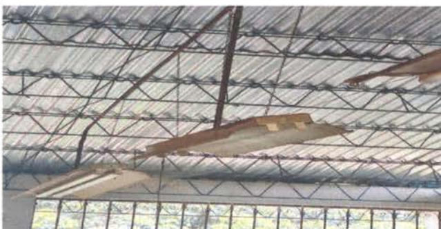
Sustitución de cableado eléctrico, cajas octogonales, plafoneras y focos en módulo de aulas
