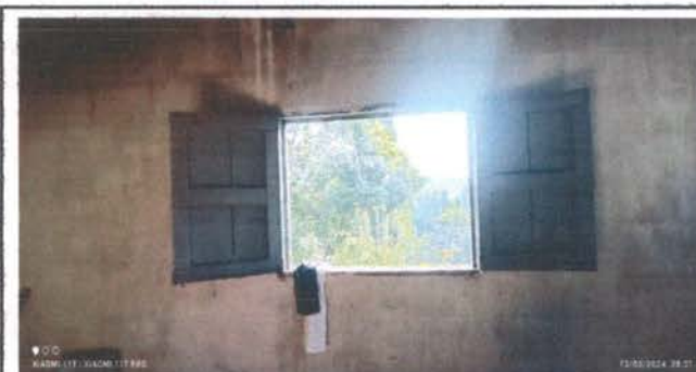
Sustitución de ventanas de madera por metal
