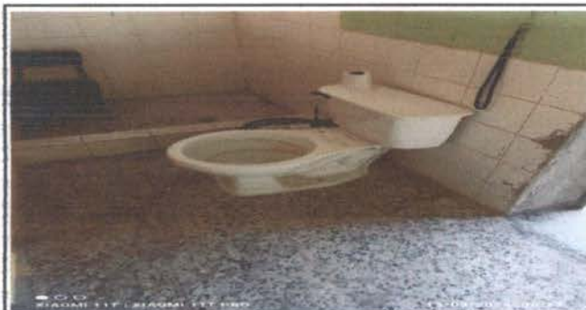
Sustitución de inodoros en servicios sanitarios
