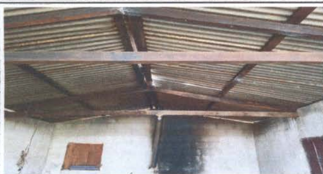
Sustitución de estructura de soporte de madera por metal y sustitución de cubierta de lámian por lámina troquelada calibre 26, sustitución de ventanas y puertas, reparación de repello y cernido en paredes de cocina
