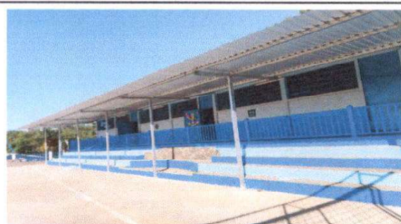
Foto 4: Sustitucion y ampliacion de lamina a lamina troquelada calibre 26 y su estructura metalica en el corredor y graderío de la cancha.
