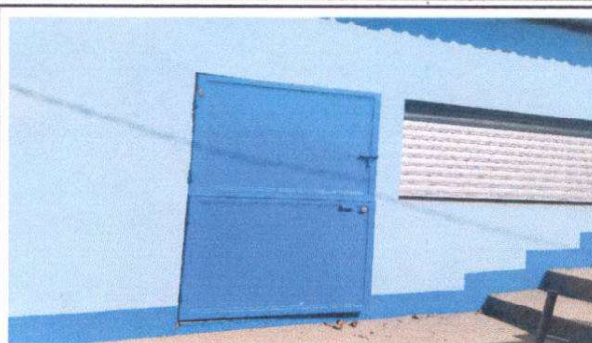
Foto 1 : Sustitución de puerta de metal en cocina.
