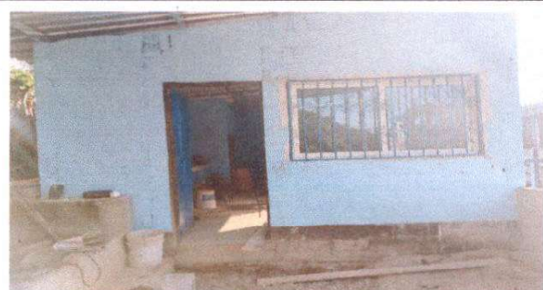
foto 5: Sustitucion de estructura de soporte de madera por metal en la cocina
