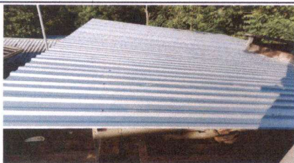
Foto 1: sustitucion de lámina, por lamina troquelada calibre 26
