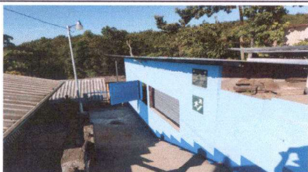
Foto 3: Sustitución de ventana de metal en la cocina
