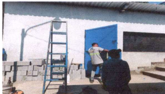
Foto 1 : Sustitución de puerta de metal en cocina.
