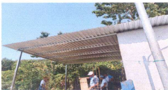
foto 5: Sustitucion de estructura de soporte de madera por metal en la cocina
