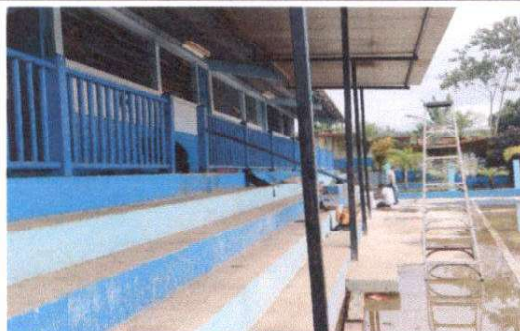
Foto 4: Sustitucion y ampliacion de lamina a lamina troquelada calibre 26 y su estructura metalica en el corredor y graderio de la cancha.
