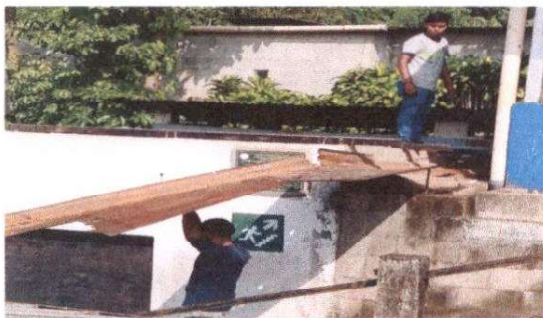
Foto 1: sustitucion de lámina, por lamina troquelada calibre 26
