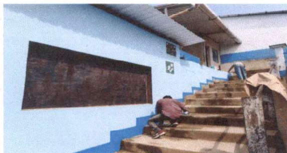
Foto 3: Sustitución de ventana de metal en la cocina
