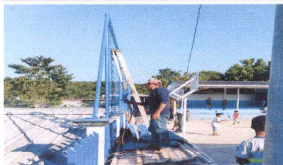
Foto 6: Instalacion de electromaya en la cancha polideportiva para proteger las aulas prefabricadas.
