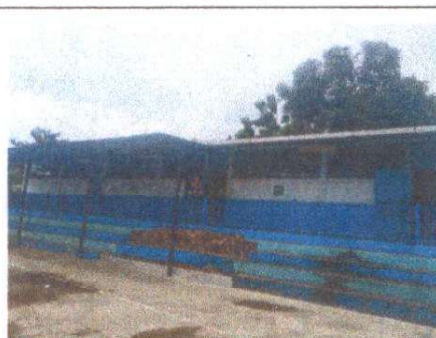
Foto 4: Sustitucion y ampliacion de lamina a lamina troquelada calibre 26 y su estructura metalica en el corredor y graderío de la cancha.
