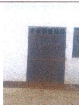
Foto 1 : Sustitución de puerta de metal en cocina.
