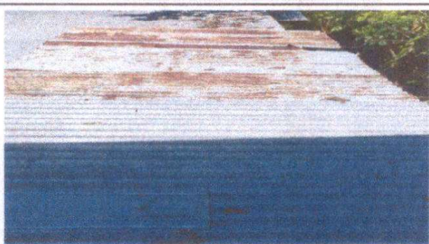
Foto 1: sustitucion de lámina, por lamina troquelada calibre 26
