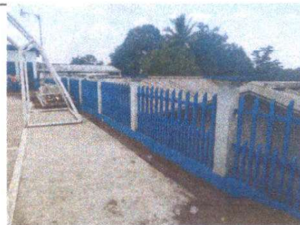
Foto 6: Instalacion de electromaya en la cancha polideportiva para proteger las aulas prefabricadas.
