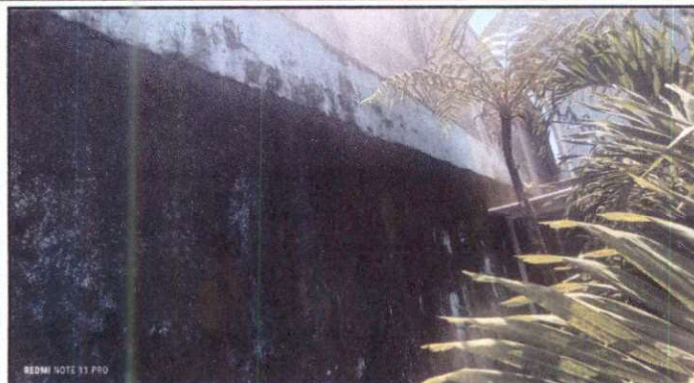
Suministro de marquesina en muro perimetral.
