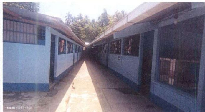
Foto 3: Reparación de losa de patio.
