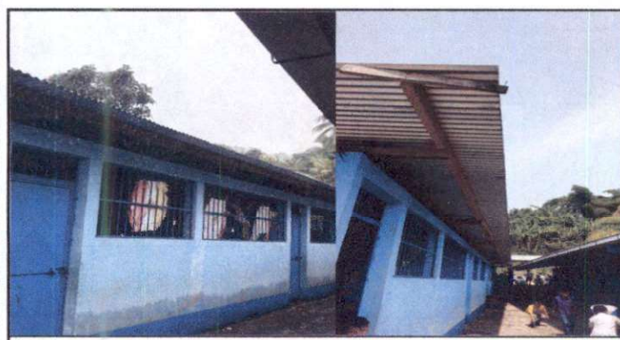
Suministro de canales UPVC, en tres aulas.
