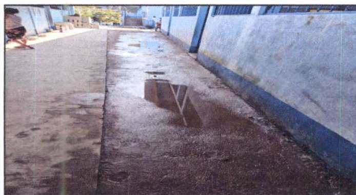
Reparación de losa de patio.
