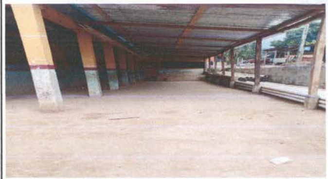
Sustitución de área de cocina
