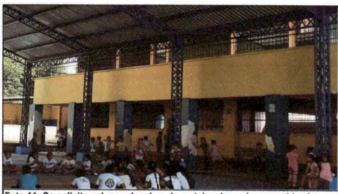
Foto 11: Se solicita colocar planchas de metal en las columnas ubicadas en la cancha, esto debido a que los niños utilizan estas columnas para trepar, poniendo en riesgo su seguridad.
