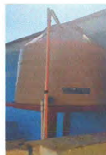
Foto 12: Instalación de depósito de agua con base metálica en el segundo nivel.
