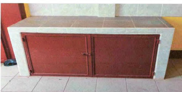
Foto 6: Instalación de mesa de trabajo con azulejo y sus respectivos gabinetes.
