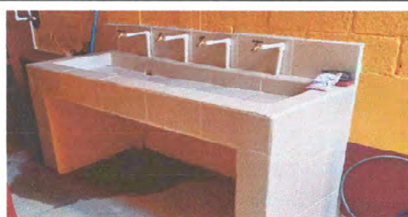
Foto 8: Instalación de lavamanos múltiple.
