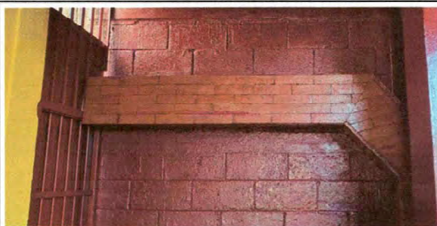
Foto 1: Reparación de puerta de acceso e instalación de chimenea de concreto recubierta con ladrillo.
