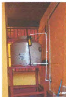
Foto 11: Instalación de depósito de agua con base metálica en el primer nivel y sustitución de bomba por una con sistema automático.
