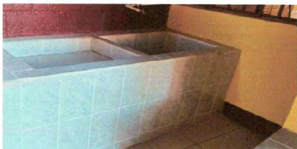
Foto 5: Instalación de pila con un lavadero más amplio y con azulejo para más higiene.
