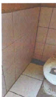
Foto 9: Se instala azulejo a un metro del suelo en los sanitarios y se coloca piso cerámico (seis en total).
