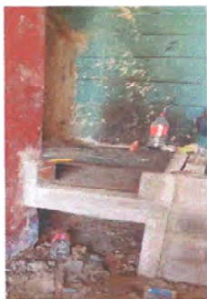
Foto 7: Inicia la instalación de estufa rural con nuevas hornillas.
