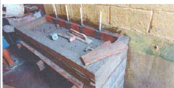
Foto 12: Sustitución de pila por un lavamanos múltiple
