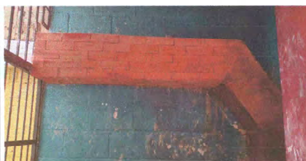
Foto 10: Se instala una chimenea a la estufa rural para evitar molestias tanto con estudiantes como cocineras.
