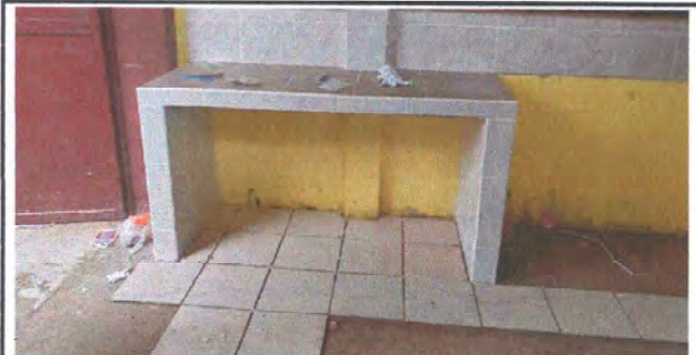
Foto 6: Azulejado de mesa de trabajo e inicio de colocación de piso antideslizante en la cocina.
