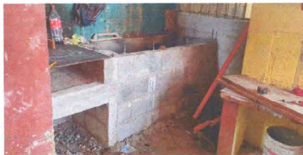
Foto 8: Instalación de nueva pila con mayor amplitud que la anterior
