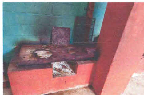
Foto 6: La estufa ya no cuenta con chimenea por deterioro, la plancha está doblada, la base de la estufa está rajada y el humo se esparce en toda la cocina.
