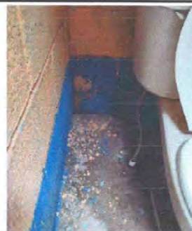
Foto 12: El piso de los sanitarios es de cemento rústico.
