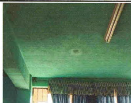
Impermeabilización de Loza
