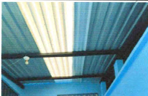
Cambio de lamina en cocina
