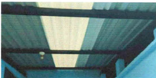
Sustitucion de estructura de soporte
