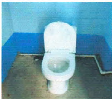
Sustitución de Inodoro
