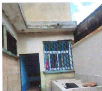
Sustitución de estructura de soporte
