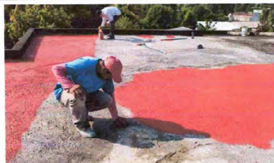
Impermeabilización de Loza
