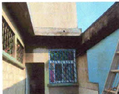
Cambio de lámina en cocina
