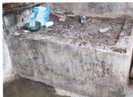
Mantenimiento a Estufa Rural
