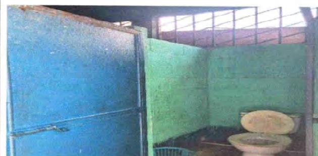
Sustitución de Inodoro
