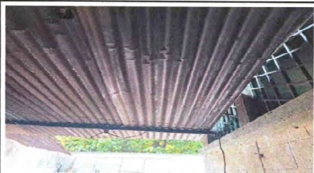
Sustitucion de estructura de soporte
