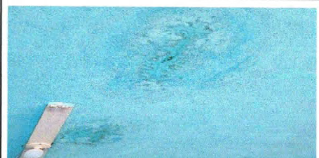
Impermeabilización de Loza
