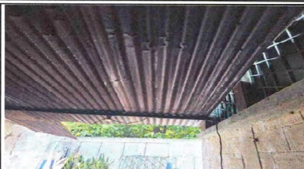
Cambio de lamina en cocina
